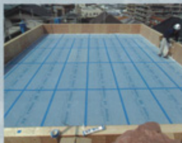
屋根は断熱材、断熱材はツーバイテン材の構造材にセルローズファイバーを235mm充填。60にスタイロフォームEX50mm厚を巻いた
