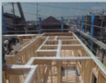
気密施工の力を借りる気密シートの先張り施工。土台・軒先・調整しめわり、外周壁と窓仕切り壁の取り付けなど、費用には気密シートを先張りし、気密面を徹底的に連続させる工夫を凝らした
