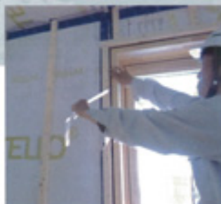
開口部の気密施工。特殊な気密補助テープで窓枠と壁の隙間を埋め、さらに室内側からコーキングする
